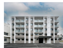
【マンション】 ツインクル1-10 旭川市1条通10丁目
