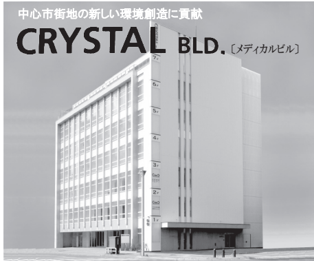
旭川市1条通6丁目78番地の1 2015年9月竣工 (自社ビル)
