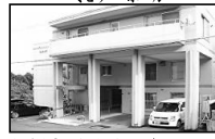
公益社 mimosa hall 西野 ミモザ ホール
